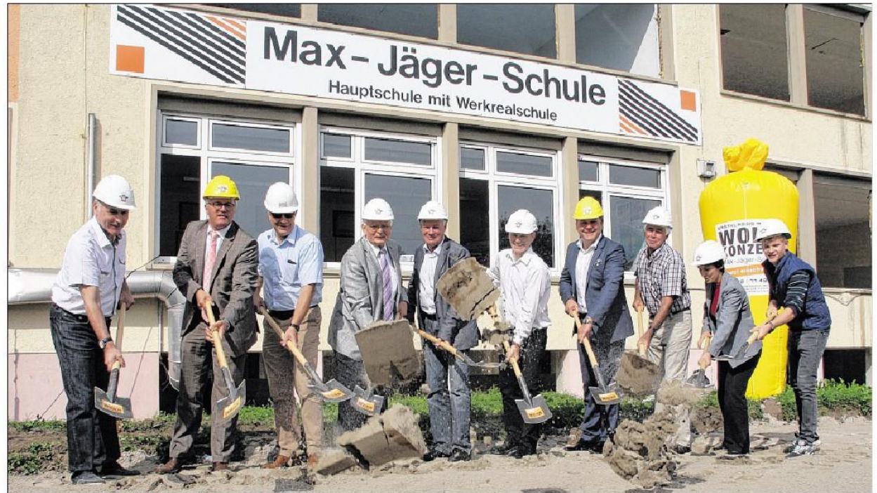
AUS EINEM SCHULGEBÄUDE WIRD EIN MEHREGENERATIONENHAUS: Groß war die Freude beim gestrigen Spatenstich vor der ehemaligen Max-Jäger-Schule. Foto: sbe
